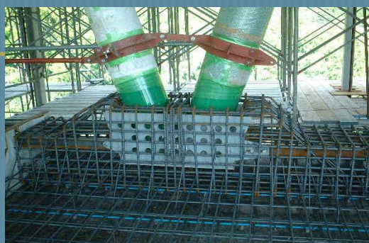
鋼製ボックス周りの配筋状況
