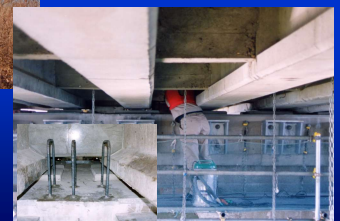
変位制限構造用 LFアンカー施工状況
