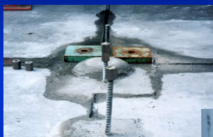
LFアンカー施工後
