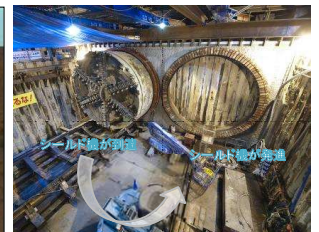
到達立坑と発進立坑の例
