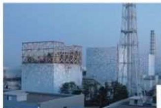
水素爆発直後の1号機原子炉建屋
