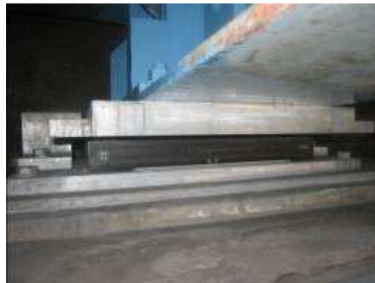
(b) ゴム支承に交換 Installing rubber bearing
