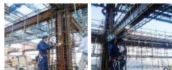
SRC建築 フレームと耐震壁の一体性
