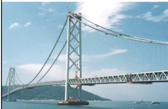
明石海峡大橋ケーブル工事(1992-1995)
