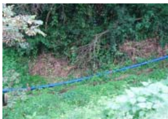
ホースを用いた仮復旧
