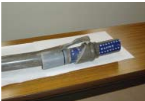
写真 - 3 塩化ビニール管破損写真
