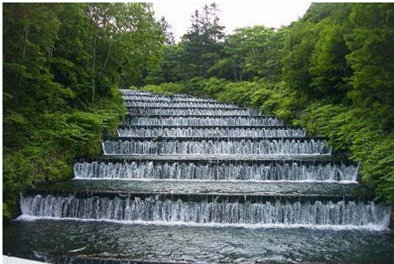
奥沢水源地水道施設
