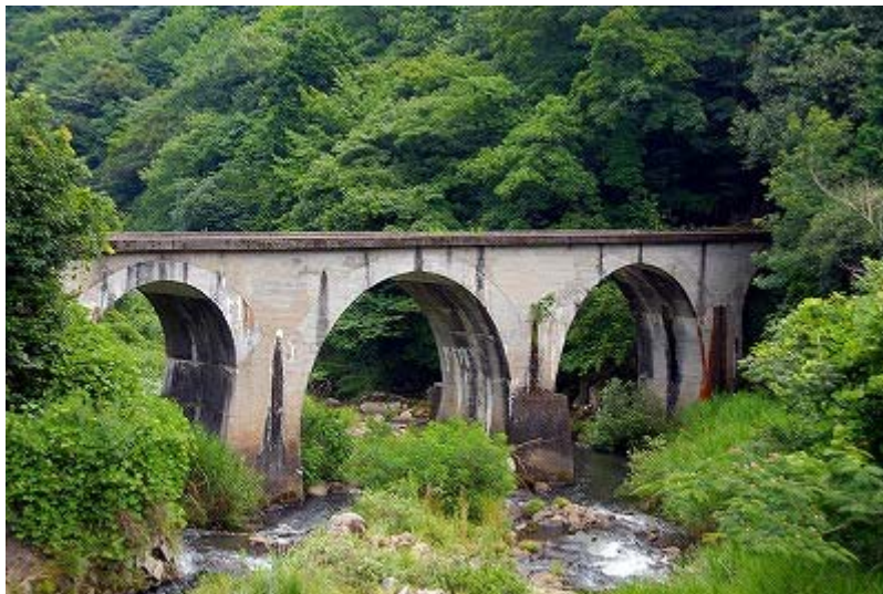
今福線のコンクリートアーチ橋群
