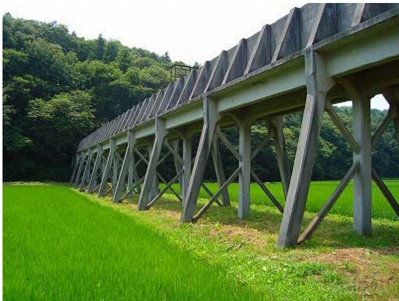
黒川発電所膳棚水路橋
