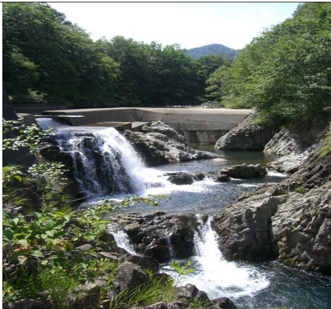
定山溪発電所施設
