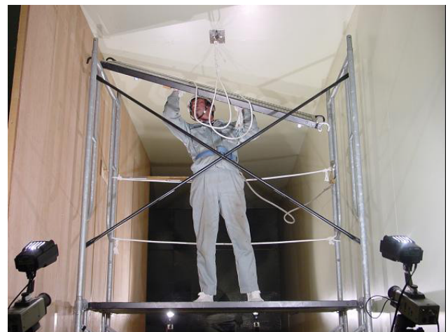
写真2 床付き布枠の取り付け・取り外し作業
