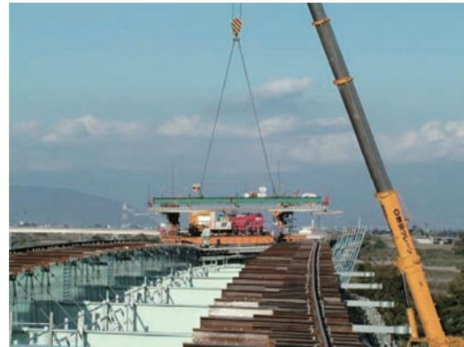
Fig. 6 PC precast deck
