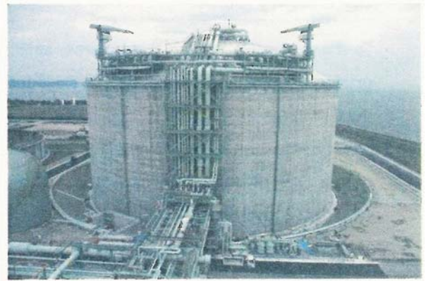
図-6 LNG地上タンク Fig. 6 LNG on-ground tank
