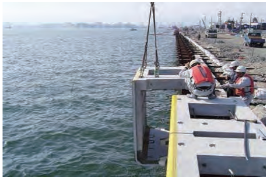
写真 3.5.1 残存型枠の据付け
