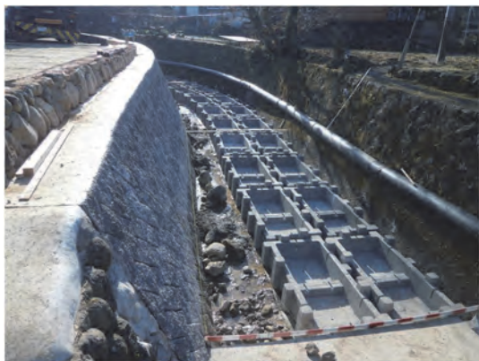
(a) 中詰めコンクリート充填前
