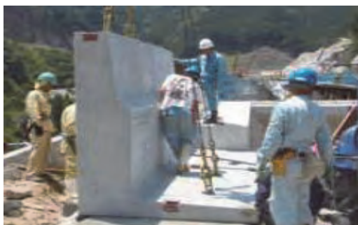
図 4.5.3 剛性防護柵一体型 L 型擁壁
