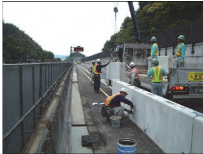
写真 2.1.3 仮設防護柵据付状況
