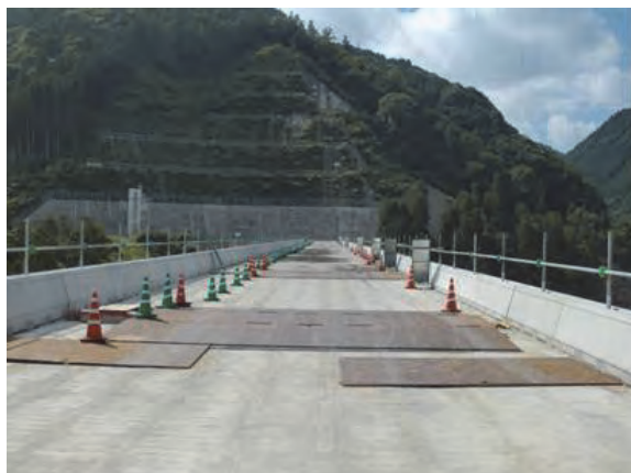
写真 4.2.2 天端道路高欄（P C a 製品）
