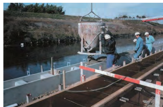
写真 3.5.2 中詰めコンクリートの打込み
