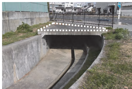
写真 1.3.1 実施事例（その 1）
