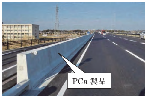
図 4.5.3 剛性防護柵一体型 L 型擁壁
