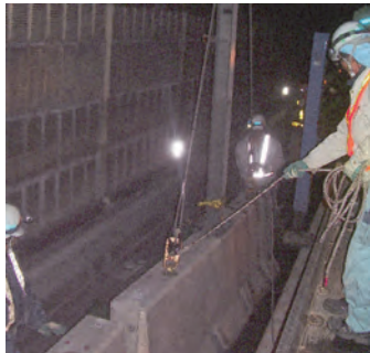
写真 2.1.5 仮設ブロック撤去
