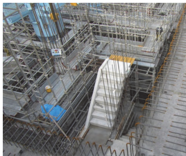
写真 4.6.1 P C a 製階段
