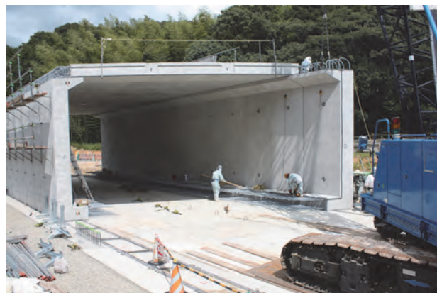
写真 1.1.3 P C a 部材の組立
