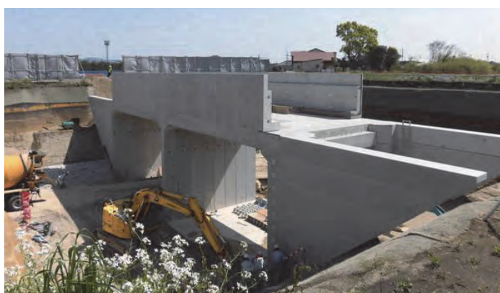
写真 1.1.5 部分プレキャスト工法による2連ボックス，P C a 製ウイングおよびP C a 製壁高欄
