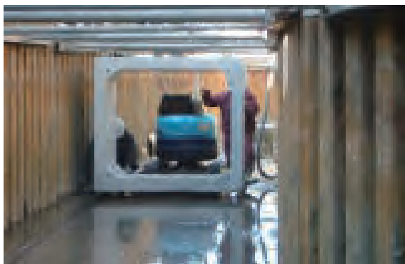
写真 4.4.5 仮設材密集現場の場合
