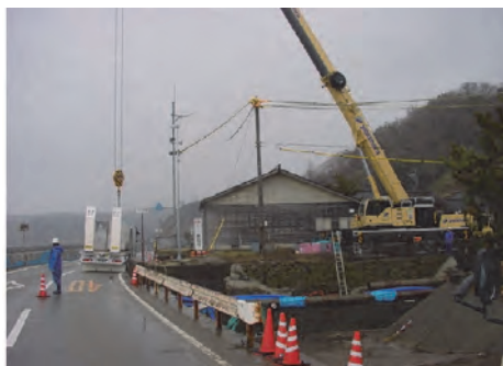
写真 1.7.4 クレーン設置状況
