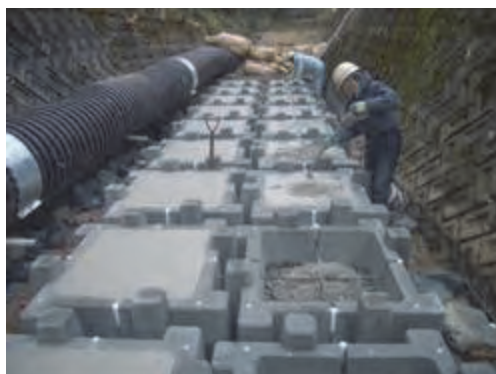
写真 3.1.2 残存型枠へのコンクリートの打込み状況
