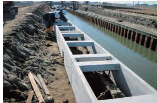
写真 3.5.1 残存型枠の据付け
