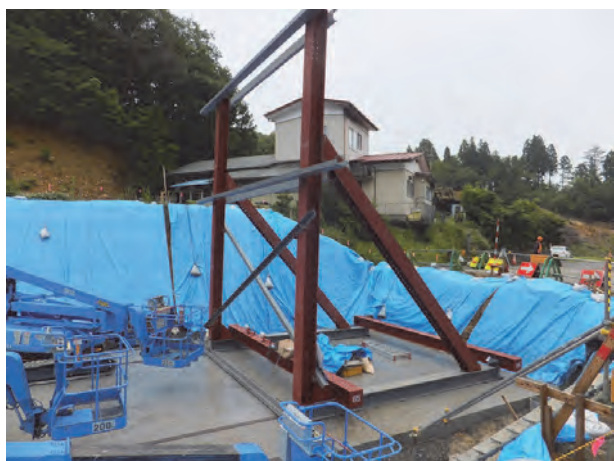
写真 1.2.1 (左) スタート部材の転倒防止用の鋼製受け台, (右) P C a 部材の組立て
