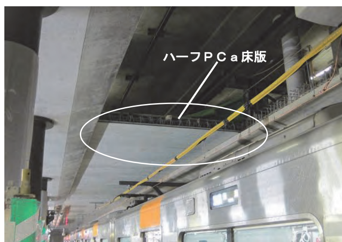
図 4.1.4 ハーフ P C a 床版設置状況
