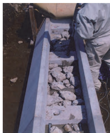
写真 3.2.3 コンクリート塊の使用
