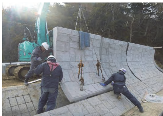
写真 3.3.2 残存型枠の据付け
