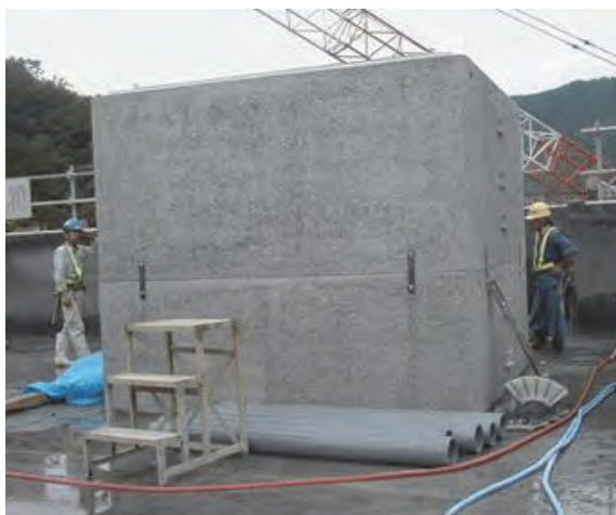
写真 4.2.1 エレベーターシャフト（P C a 製品）
