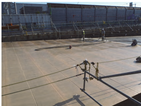
写真 1.8.3 外面吹付防水の施工状況
