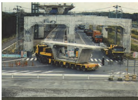
写真 2.3.1 セグメントの運搬
