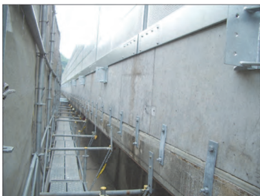
写真 2.1.11 施工完了(背面側)
