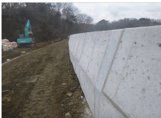
写真 3.3.3 陸側型枠の撤去
