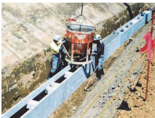
写真 3.2.2 中詰めコンクリートの打込み
