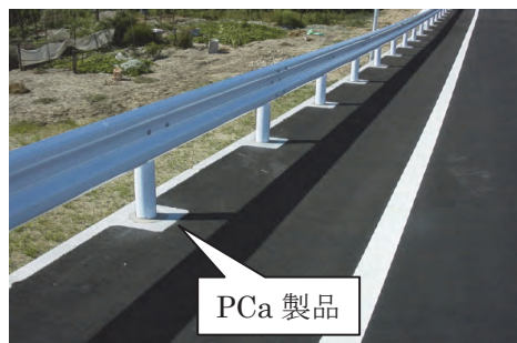
図 4.5.2 防護柵建込用 L 型擁壁
