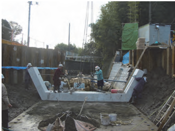
写真 1.5.3 下部ブロック据付け
