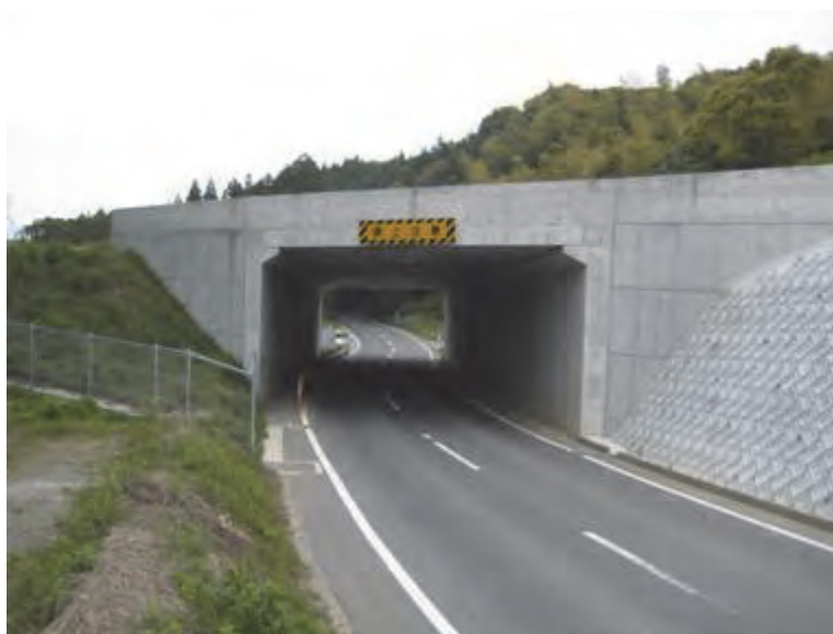
写真 1.1.1 部分プレキャスト工法による斜角を有する大型ボックスカルバートの構築事例
