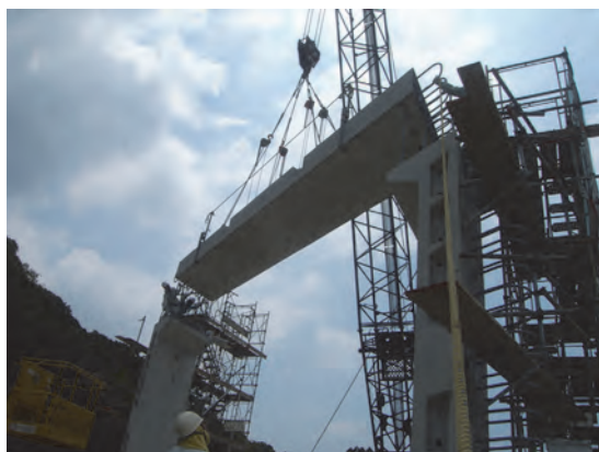
写真 1.1.3 P C a 部材の組立
