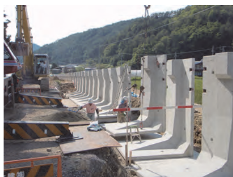
写真 4.5.1 P C a 製品の据付け
