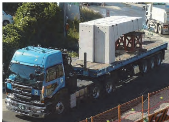
写真 1.4.1 隅角部材の運搬状況
