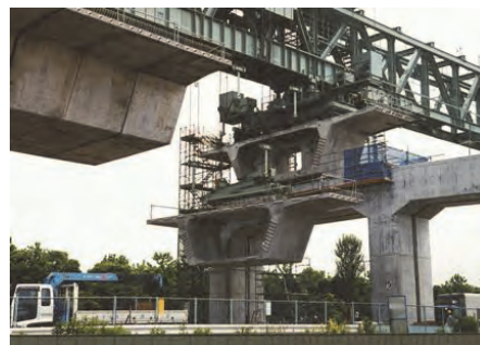
写真 2.3.2 スパンバイスパン架設
