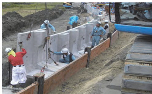
図 4.5.2 防護柵建込用 L 型擁壁
