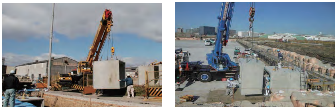
写真 4.4.1 クレーンによる P C a 製品の据付け事例
