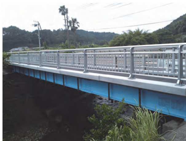
写真 2.2.2 完成後の状況
