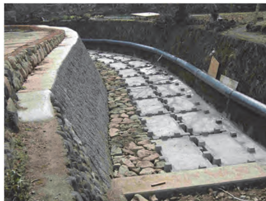
(b) 中詰めコンクリート充填後
