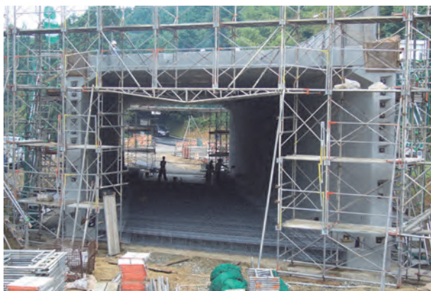
写真 1.1.4 底版配筋後-現場打ちコンクリートの打込み・一体化
