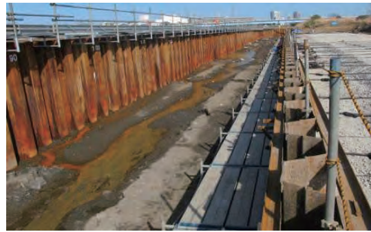
図 3.5.3 仮締切りを採用した施工事例
