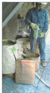
写真 2.1.9 無収縮モルタル 練混ぜ状況
