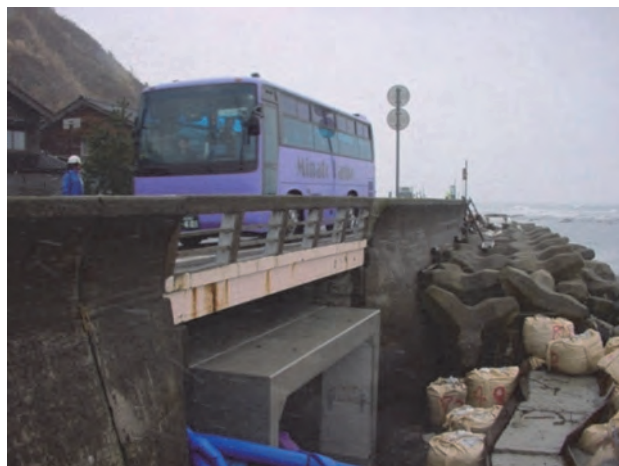
写真 1.7.2 施工中における既設橋梁の車両通行状況
