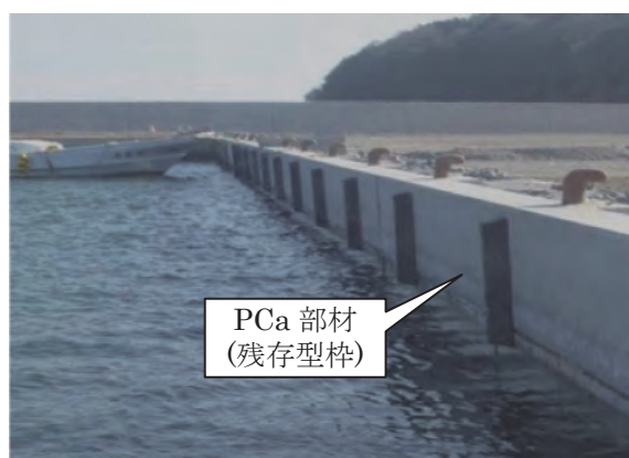
図 3.4.1 残存型枠による岸壁の構築
