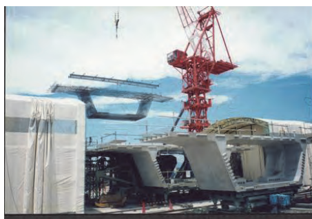
写真 2.3.3 ショートラインマッチキャスト方式
