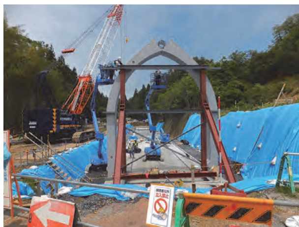
写真 1.2.1 (左) スタート部材の転倒防止用の鋼製受け台, (右) P C a 部材の組立て
