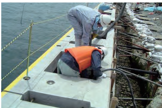
写真 3.5.2 中詰めコンクリートの打込み
