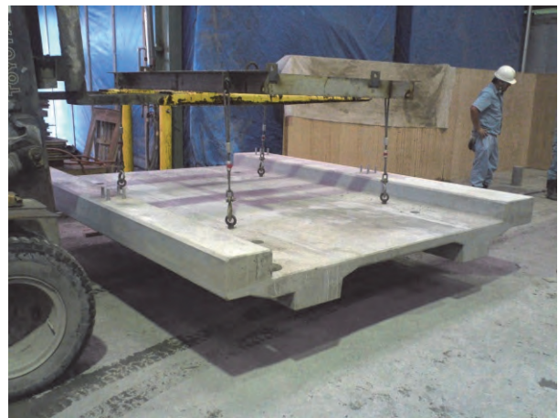
写真 2.2.5 工場製作状況
