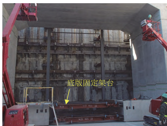
図 1.8.2 底版固定架台
