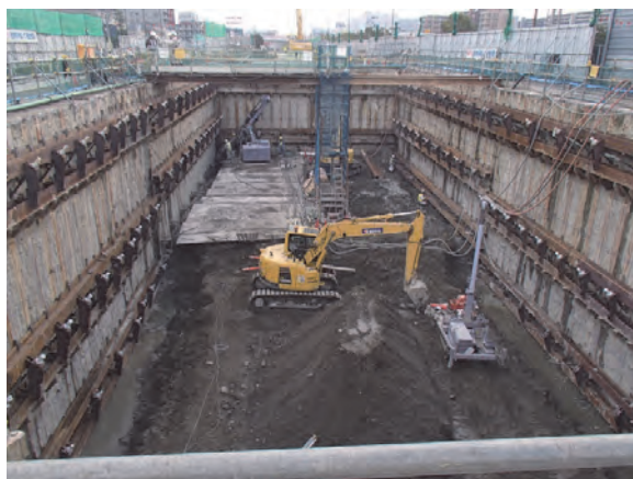
写真 1.8.2 掘削および支保工施工状況
