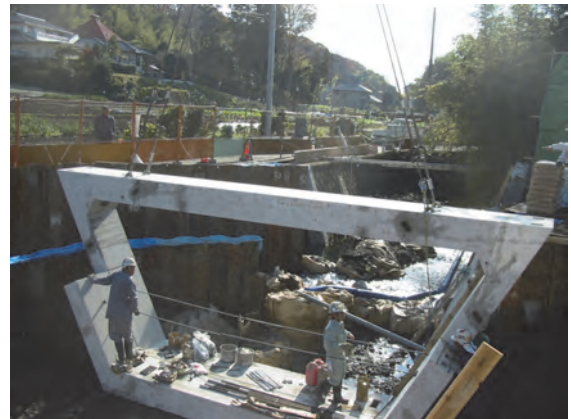
写真 1.5.4 上部ブロック据付け
