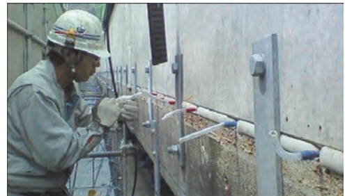
写真 2.1.10 無収縮モルタル グラウト状況
