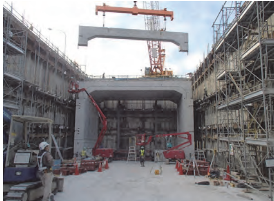
写真 1.8.1 プレキャストボックスカルバート施工状況
