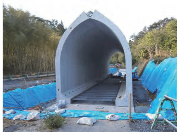
図 1.2.1 部分プレキャスト工法の活用による大断面アーチカルバートの構築
