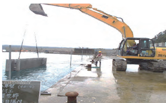
写真 3.4.3 残存型枠の据付け
