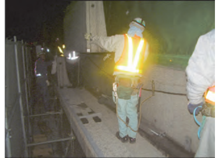
写真 2.1.7 ブロック設置状況 1
