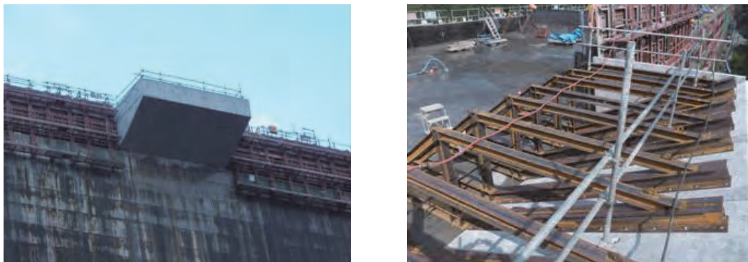
写真 4. 2. 3 洪水吐部に P C a 製の残存型枠を利用
