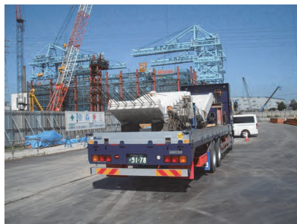
写真 4.6.2 P C a 製階段の搬入状況
