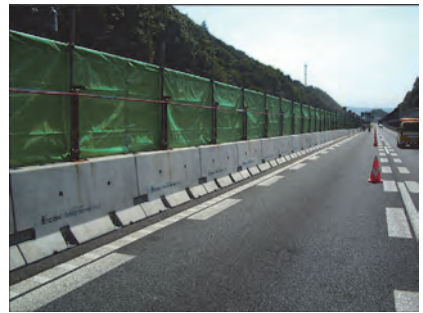
写真 2.1.4 仮設防護柵設置完了
