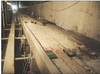
写真 2.1.6 高さ調整プレート ・シールパッキン設置
