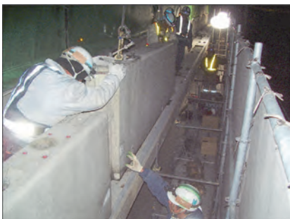
写真 2.1.8 ブロック設置状況 2
