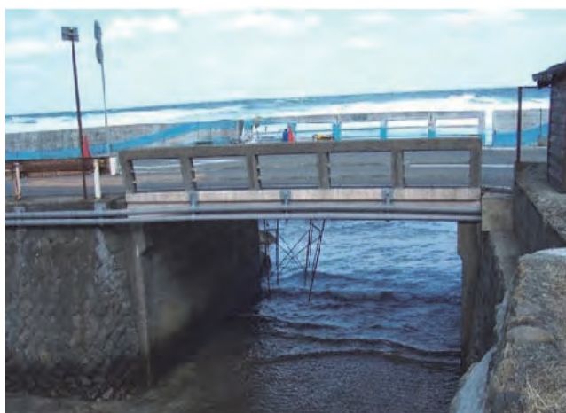
写真 1.7.3 補修前の状況
