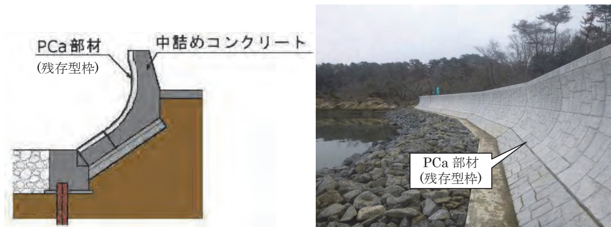
図 3.3.1 残存型枠により施工した海岸の波返し
