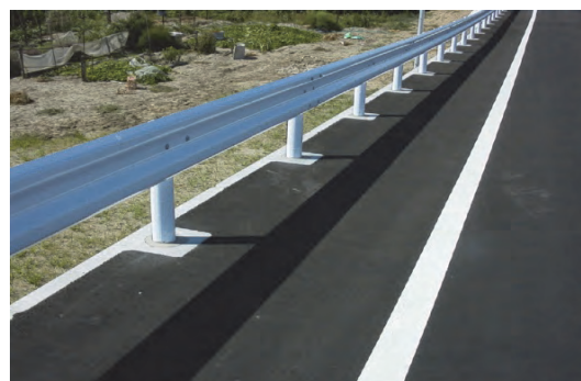
写真 4.5.2 防護柵の建込み
