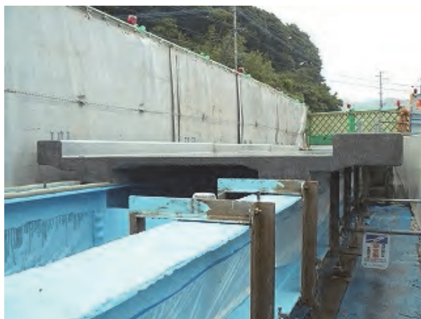
写真 2.2.1 床版施工状況
