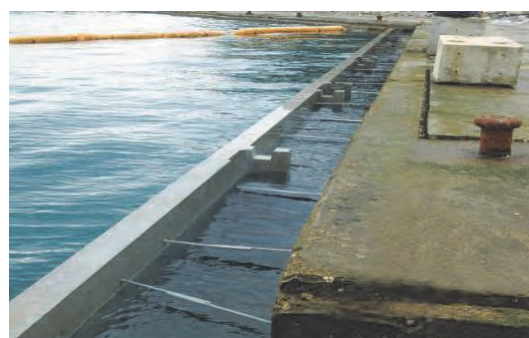
写真 3.4.4 セパレータによる連結
