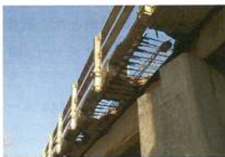
図 4-8. 事業対象橋梁の損傷例
