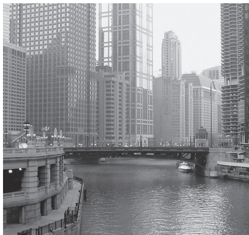
写真1 シカゴ市内ワバシュ通り橋 橋の端の小さな塔のようなものは開閉操作室、下がシカゴ川。
