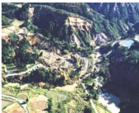
(a) 斜面崩壊による中山間地の孤立化
