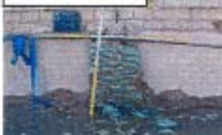
No.5-6ケーソン目地
