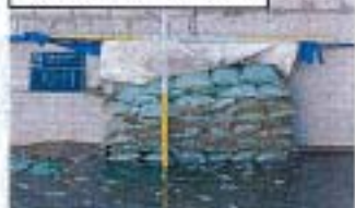
No.10-11ケーソン目地
