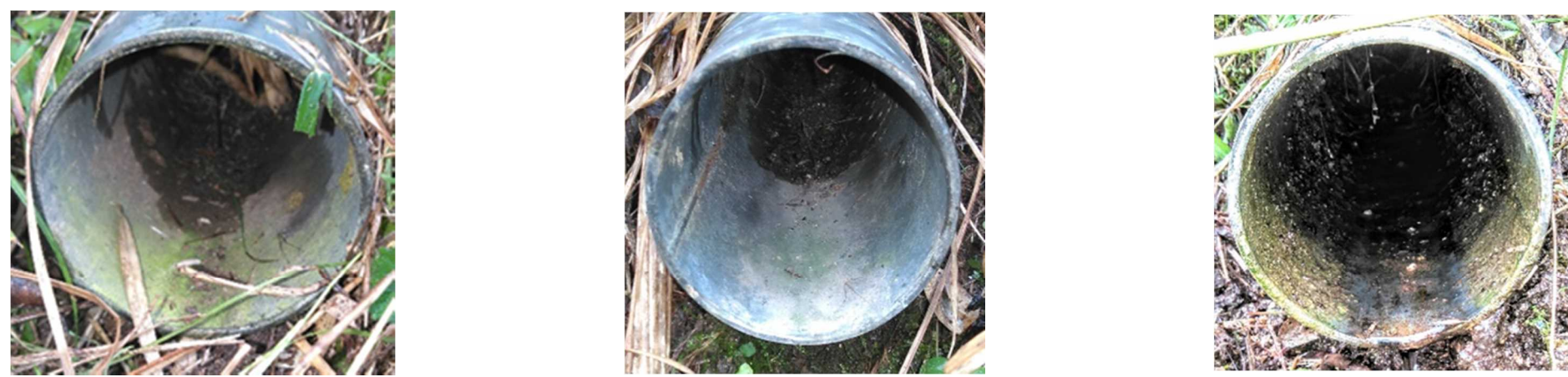
写真-3 排水パイプ出口(左:上段, 中:中段, 右:下段)
