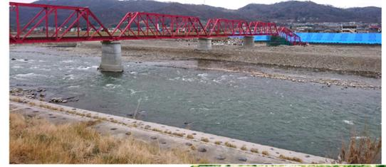
図1 堤防欠損による落橋の様子 (2020年1月17日撮影)
