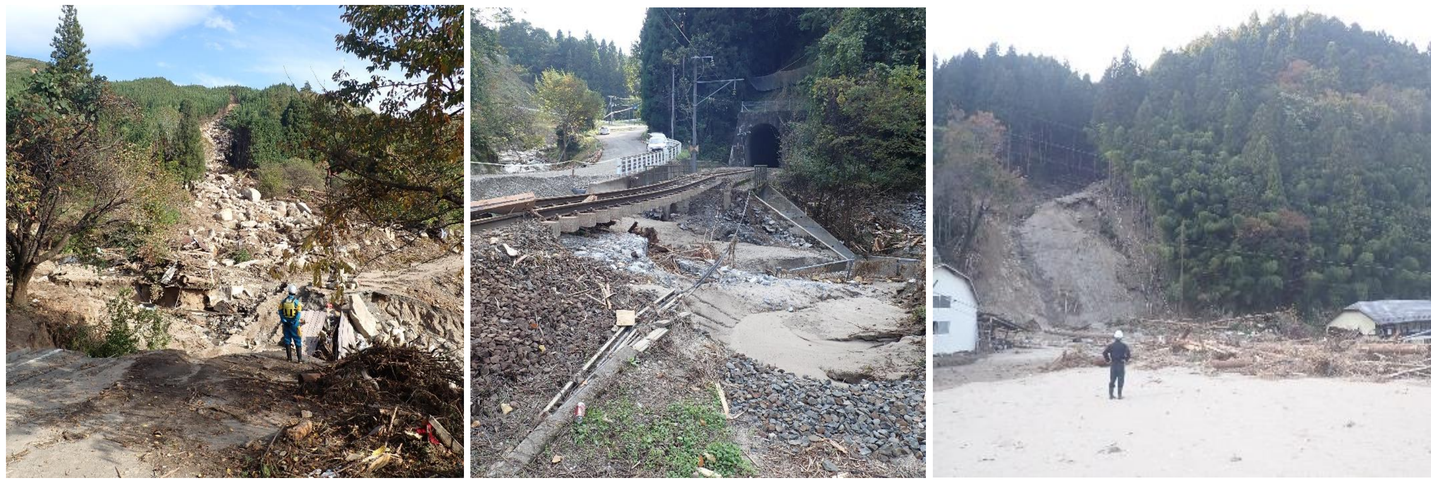
子安地区(廻倉)の土砂災害
