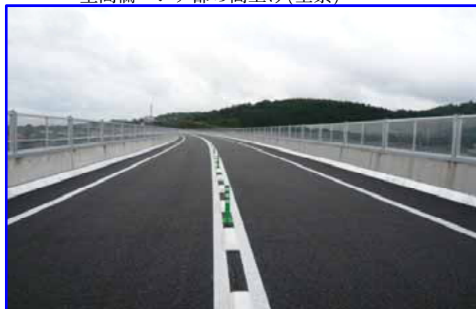
壁高欄ハンチ部の嵩上げ(全景)
