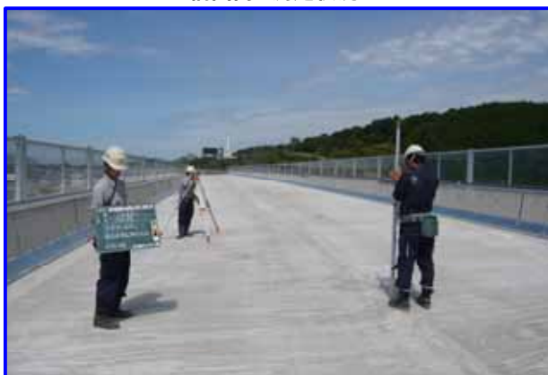
橋面高さ測定状況
