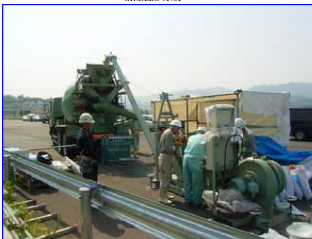
鋼繊維投入状況
