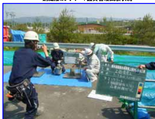
鋼繊維コンクリート品質管理試験状況
