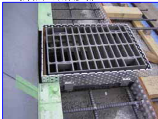
排水柵嵩上げ(増厚施工前)
