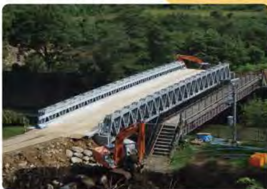
応急組立橋(B活荷重 40m 2車線)
