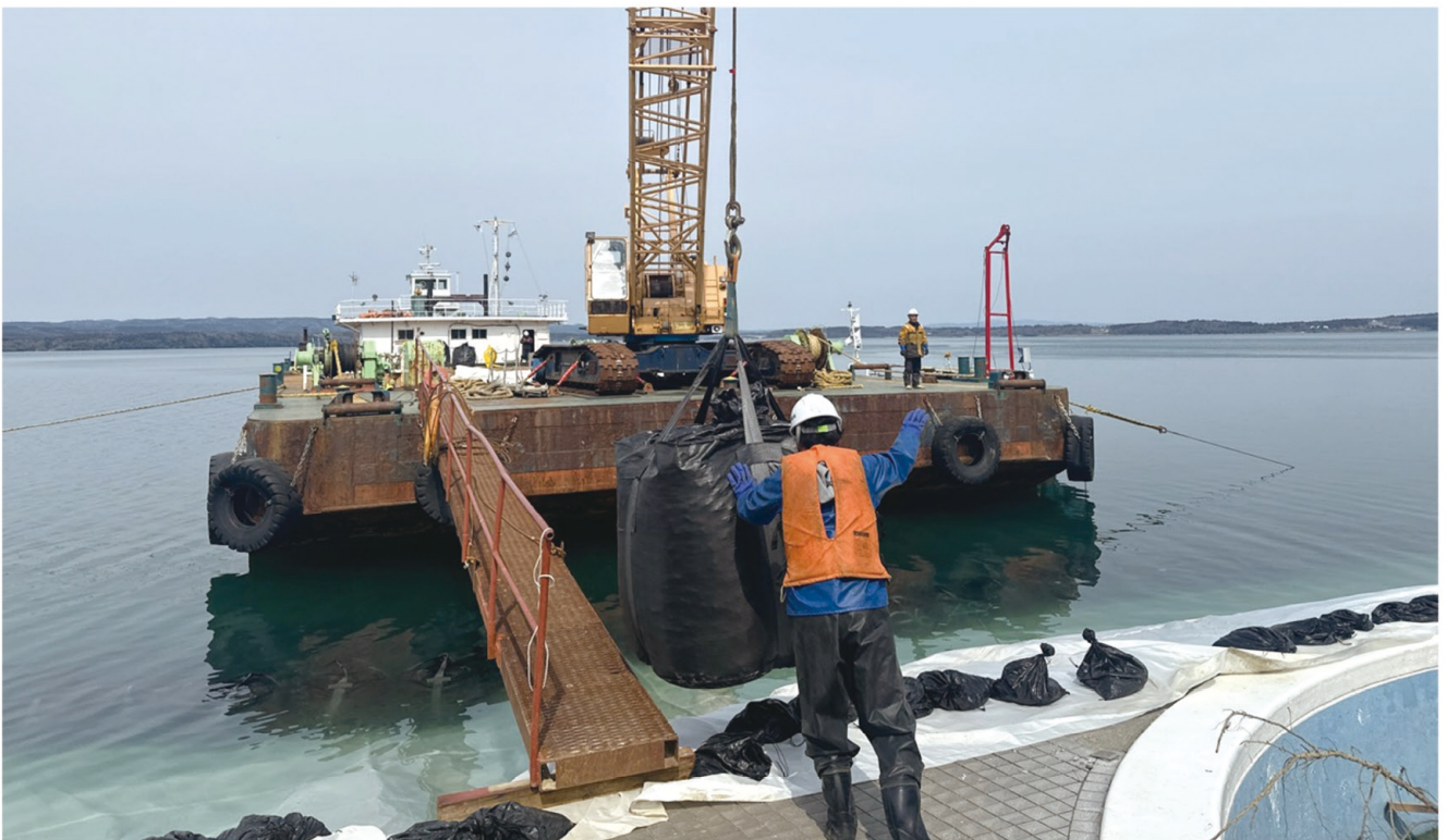
和倉港、和倉港海岸で土木シート、大型土のうを設置している様子
