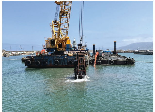
輪島港での航路啓開作業。水深を確保するための浚渫
