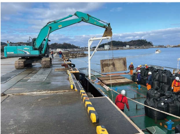
新世丸で海上輸送した敷鉄板(通路用)を輪島港で荷下ろす
