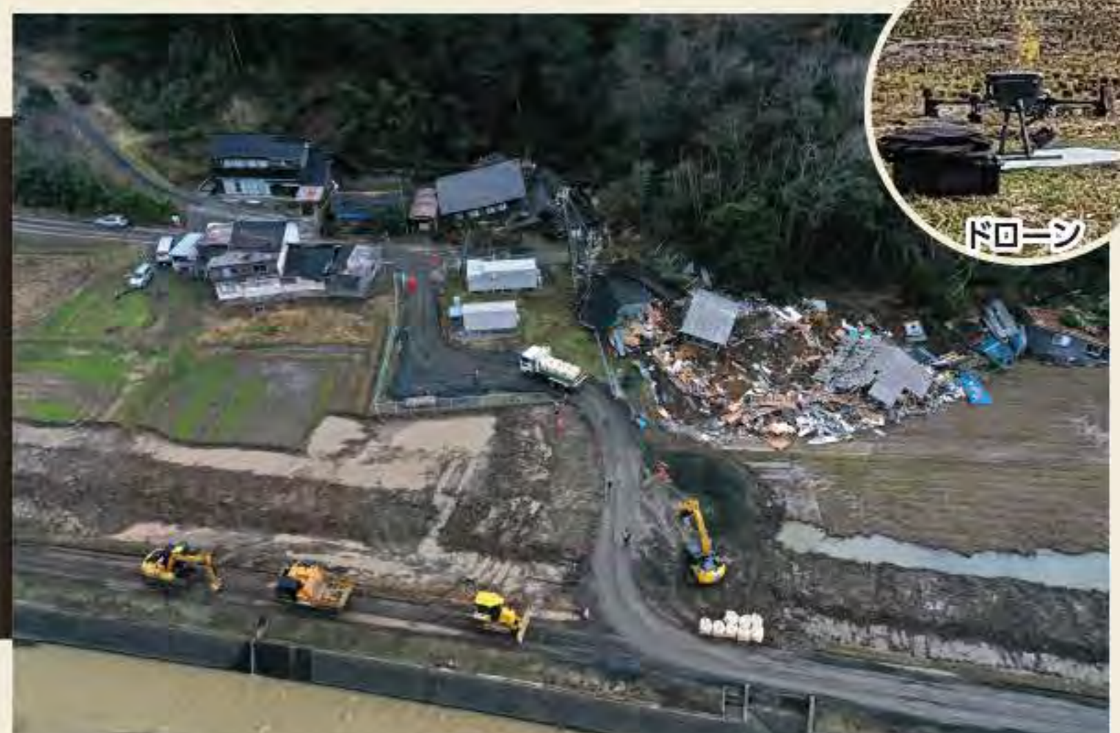
ドローンを用いた被災調査
