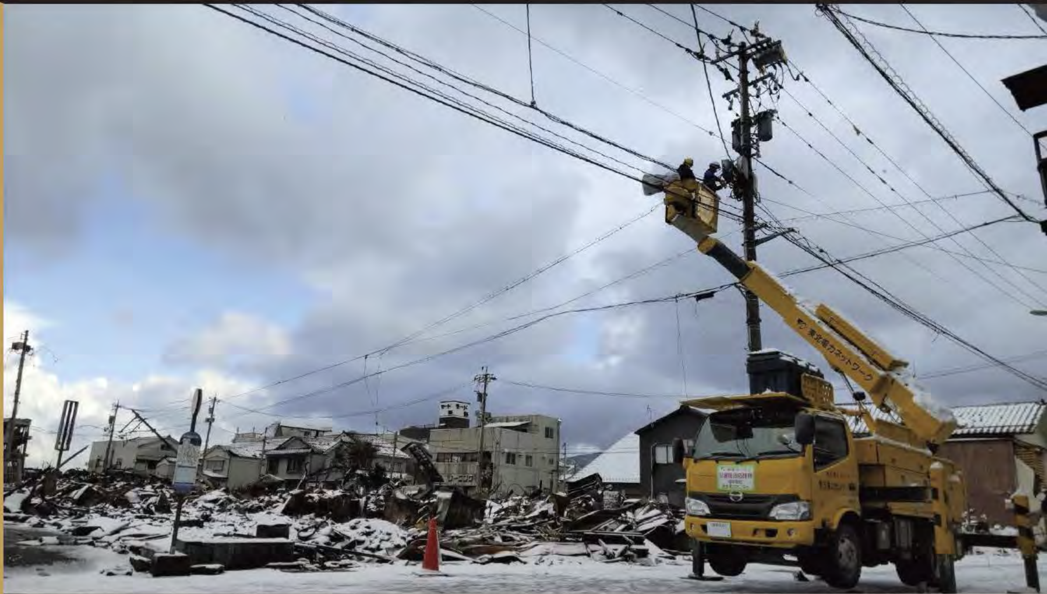
被災地での電源復旧作業の様子の様子
