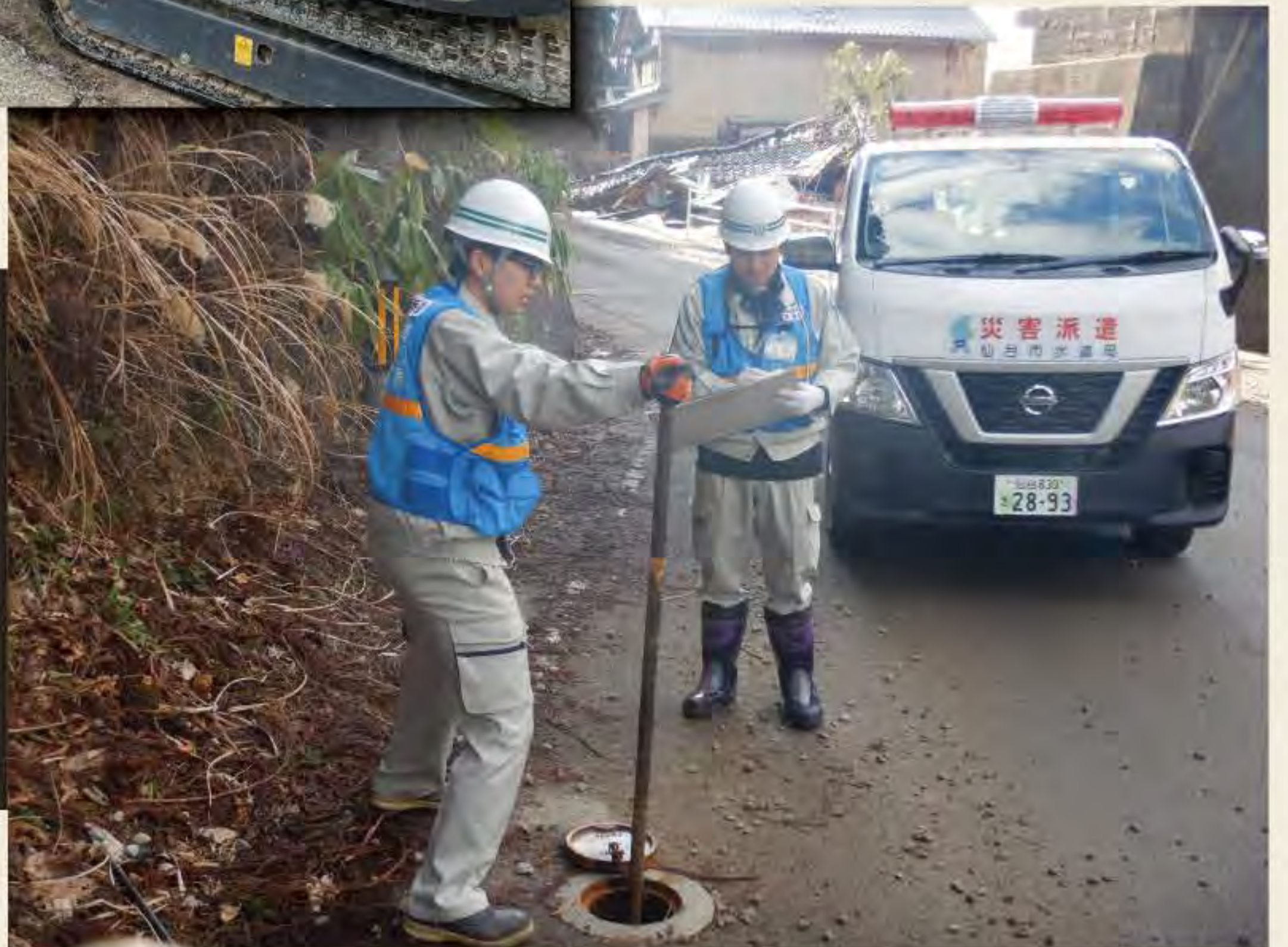
飯田地区 水道管バルブ調査の様子 （令和6年2月3日）
