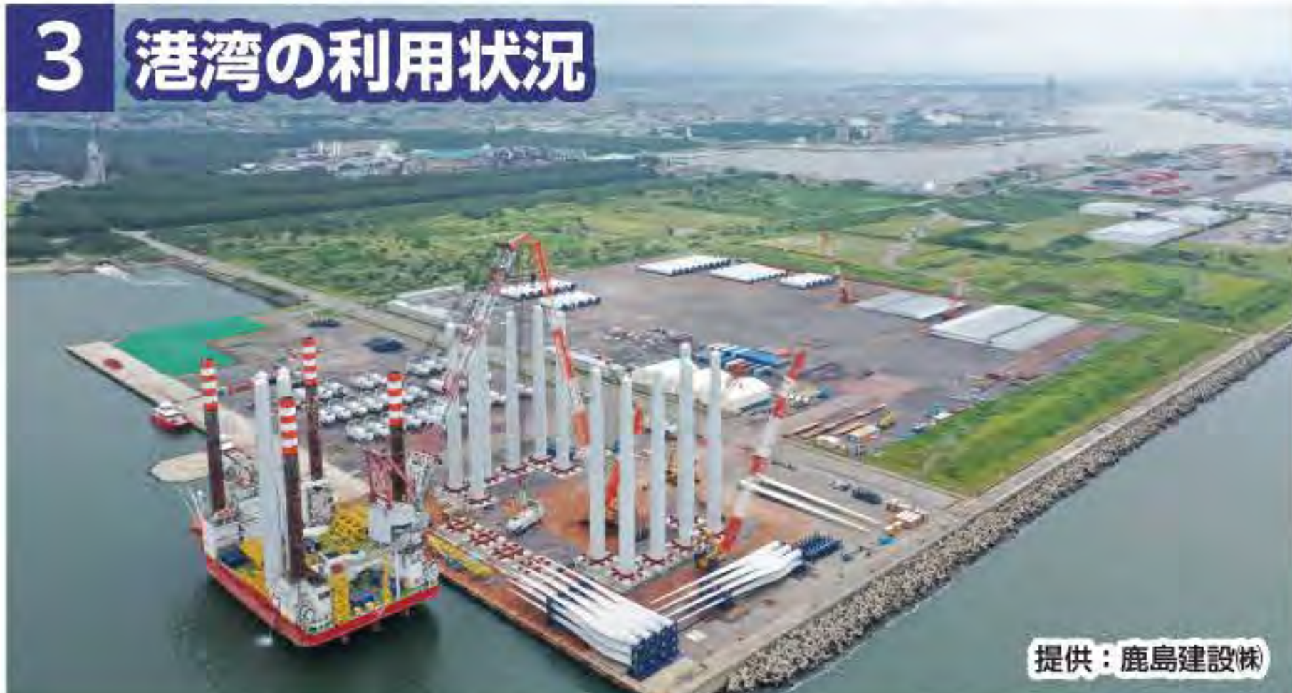
※洋上風車の部材を扱うために地盤強化工事を実施
