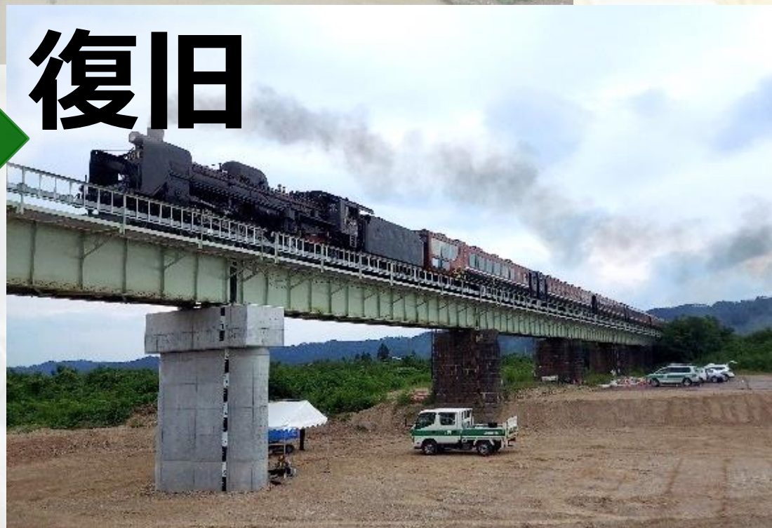
磐越西線 濁川橋りょう洗堀災害
