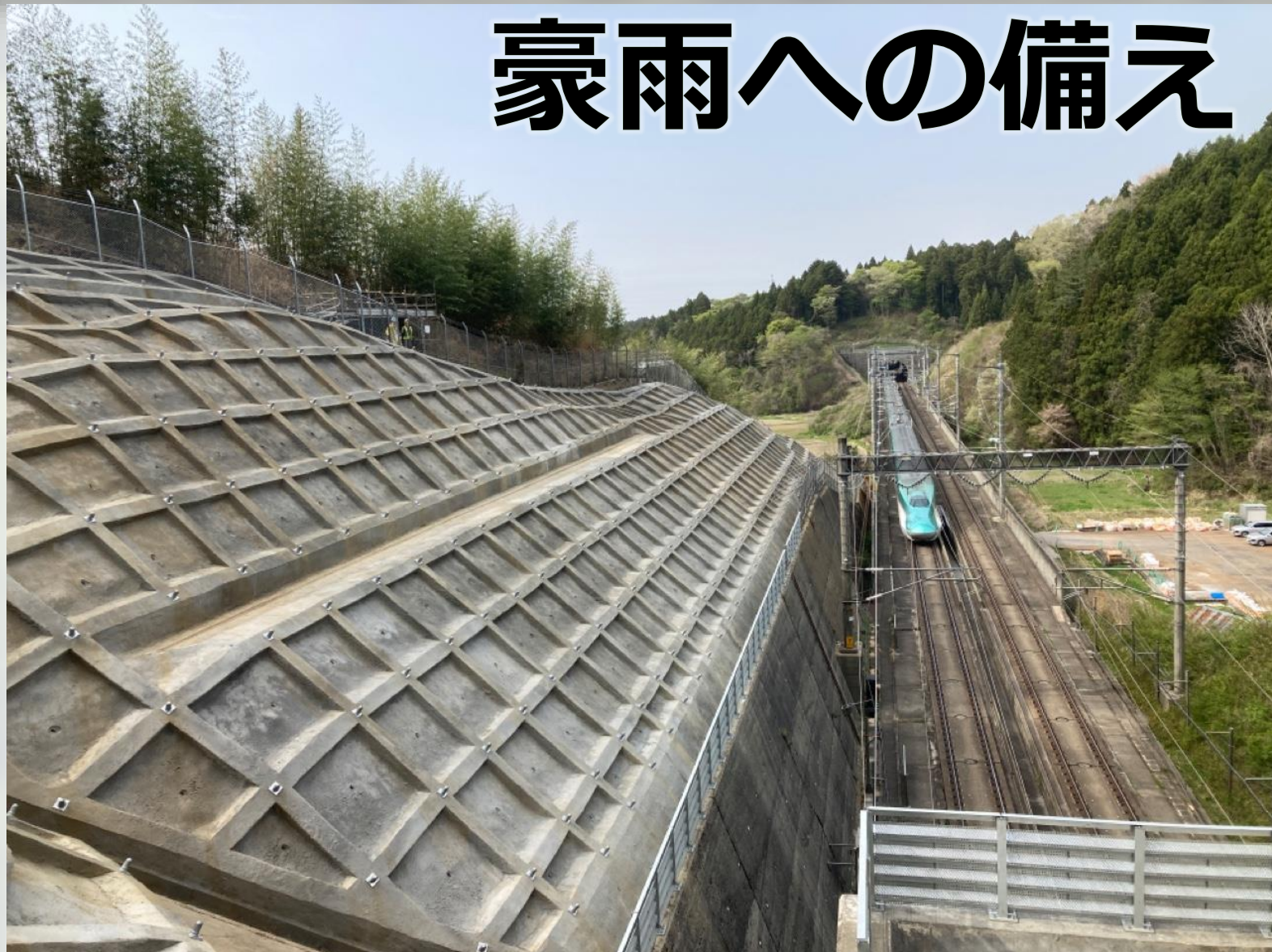
東北新幹線 降雨防災工事
