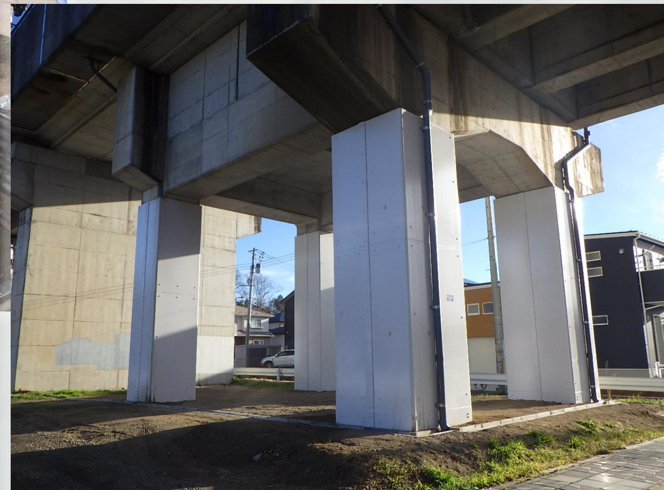
新幹線高架橋 耐震補強工事
