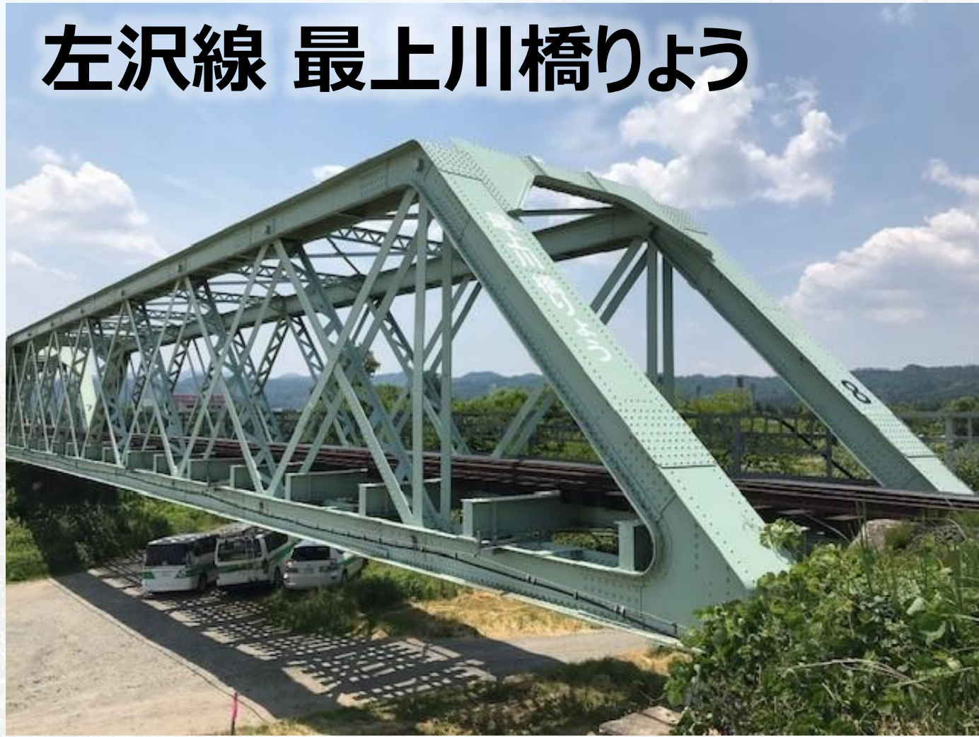
現役最古の鉄道鋼橋りょう 経年138年
