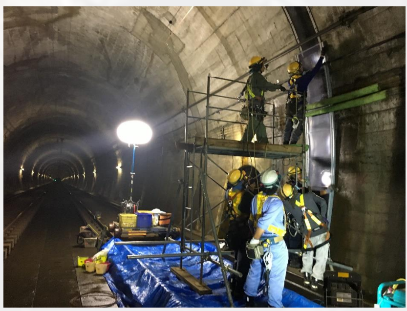
修繕工事を実施・監督
