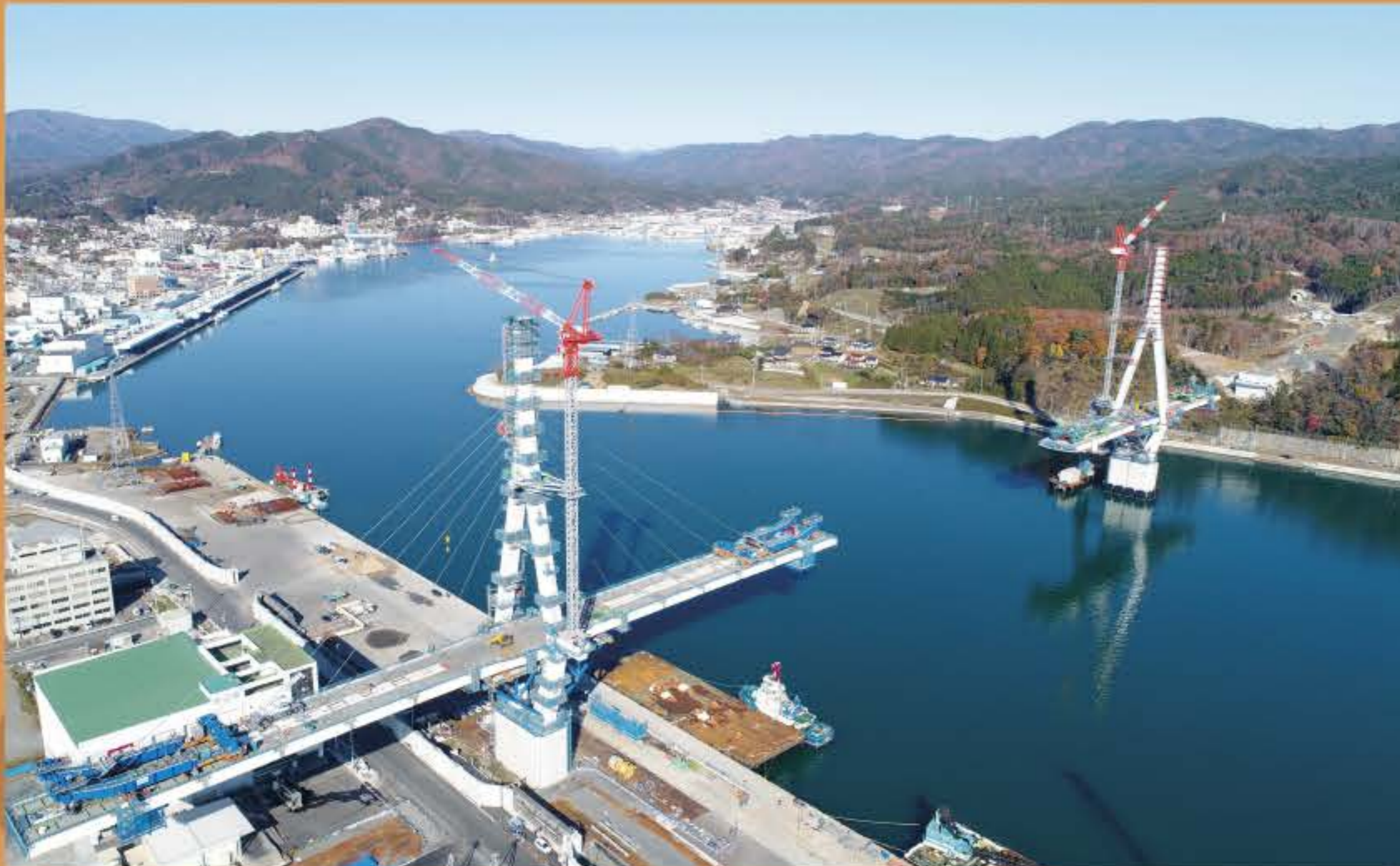
建設中の 気仙沼湾横断橋
