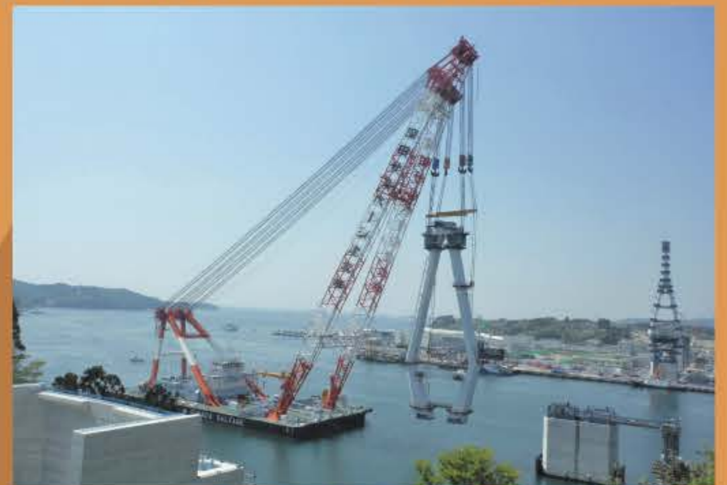
海上部の 主塔の架設
