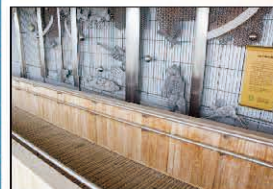
スロープ （3階送迎デッキ）
