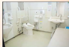
多機能トイレ （1～3階・待合室）
