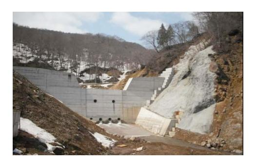
耕英東砂防激特事業完成 平成25年(2013) 岩手宮城内陸地震に伴う大規模な土石流、多量 の堆積土砂が再び下流域に流出するのを防ぐた め、砂防堰堤4基、床固工3基、帯工10基からなる 砂防施設群を整備しました。
