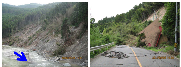
(a) 河川左岸斜面の崩壊 (b) 道路に沿った斜面の崩壊
