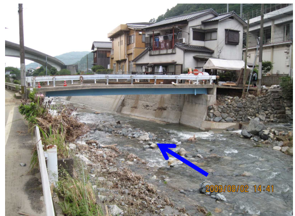
図-5 篠栗町山手公民館の裏側を流れる多々良川 (右岸側の建物の向こうに国道201号が通っている)
