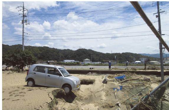
写真-2 船木大橋上流右岸の侵食被害の様子<sup>7)</sup>
