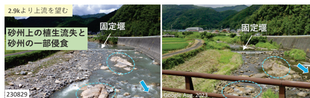
図-12 岩盤河床を有する固定堰下流の出水前後の河床の変化 (右側はGoogle Mapsの画像 6) )
