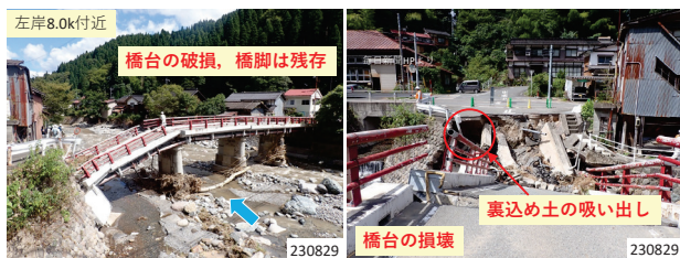
図-13 橋梁損壊の状況 (8.0 k, 高山地区)
