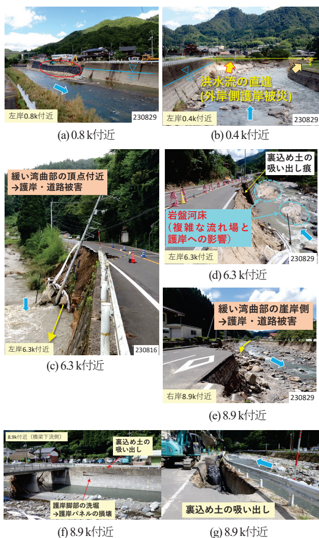
図-10 出水に伴う護岸の崩壊と道路の崩落状況
