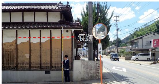
図-9 高梁市落合町阿部地区の浸水深2.8mの状況<sup>5)</sup>
