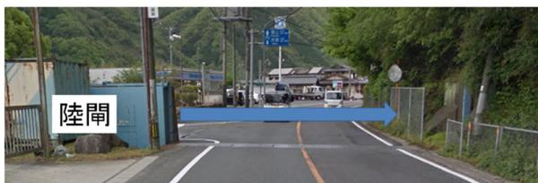
図-15 奥に見える落合町阿部地区への浸水を防ぐ陸間<sup>5)</sup>
