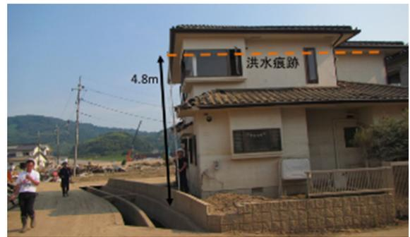
図-6 真備地区の浸水深4.8mの状況<sup>4)</sup>
