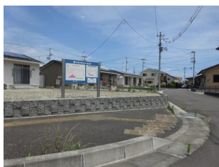
写真-2 住宅の盛土
