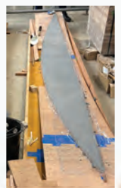
④底面打設
