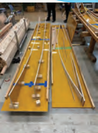
①型枠製作
