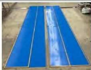
型枠には2cm幅のベニアを貼る
