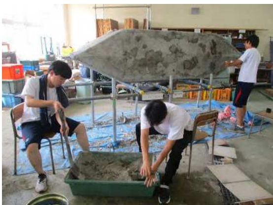
モルタル打設
