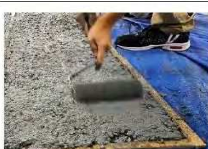
コンクリート打設
