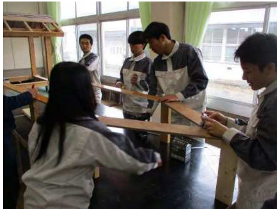
型枠組み立て
