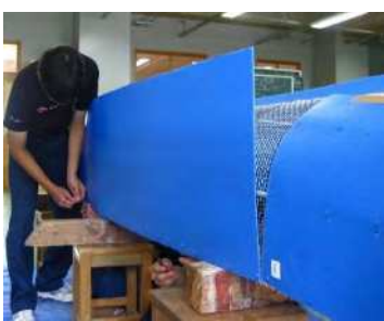
外面型枠設置
