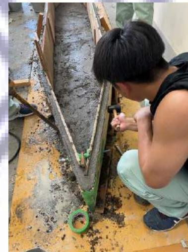
図5 締固め
