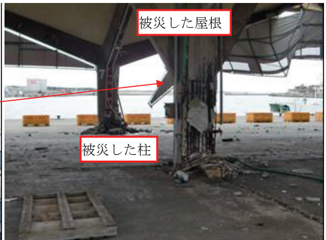
写真4 被災した柱
