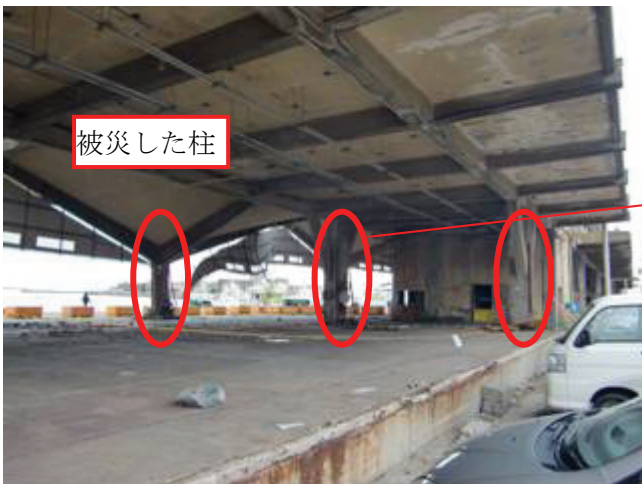
写真3 被災した柱
