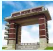
荒川ロックゲート
