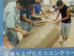
⑤練り上げたエココンクリートを金ゴテで型枠上に薄く塗り広げる
