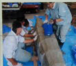
<コンクリート打設>
