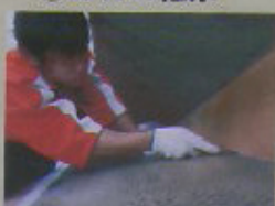
⑧型枠の解体
