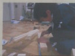
①型枠の墨付け
