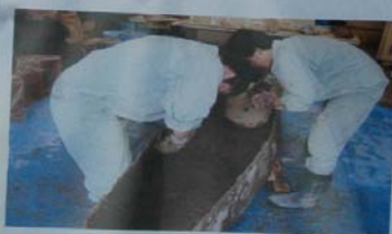
<Round4 型枠脱型>
