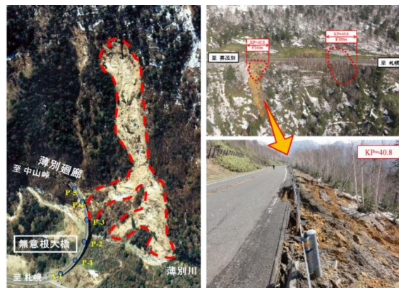
写真-1 国道230号中山峠の被災状況
