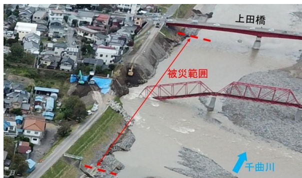
図-4 被災箇所の状況(2019.10.23 上流から撮影)
