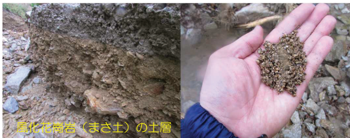
一般国道274号(清水町側)7合目周辺の状況
