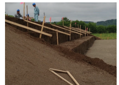
2割堤完成後の段切り状況 (令和2年6月16日撮影)
