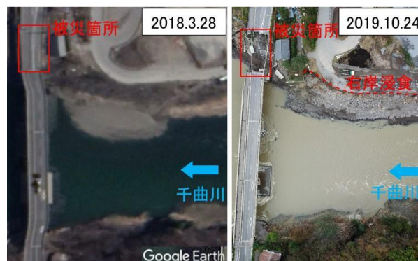
図-7 被災箇所の状況 (2019.10.24 下流から撮影)
