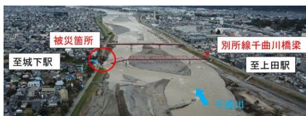
図-3 千曲川橋梁の全景(2019.10.23 上流から撮影)
