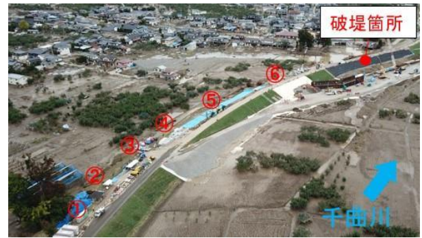
図-12 破堤箇所上流の状況(2019.10.24 撮影)
