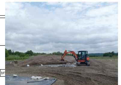
3割堤施工状況 (令和2年6月23日撮影)
