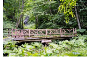
木コンクリート橋・木直川橋
