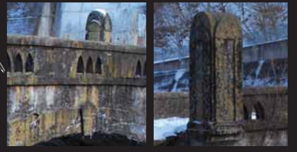
高欄の尖塔アーチ型開口・要石のレリーフと交差ボルト型の親柱
