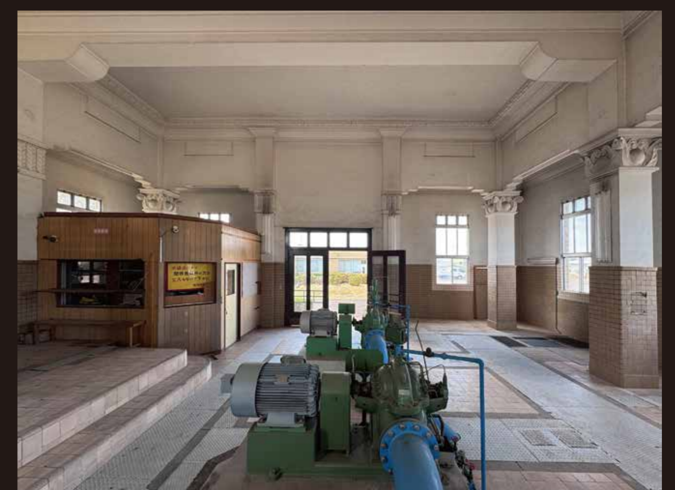
▲ 旧ポンプ室内観：機械類は、建設当時、三台のポンプが設置されていた。住原製作所製であった。モーターは芝浦製作所製で出力40馬力あり、配水塔への揚水に使用されていた。現在は2004年度に更新された2台のポンプ・モーターが残されている。
