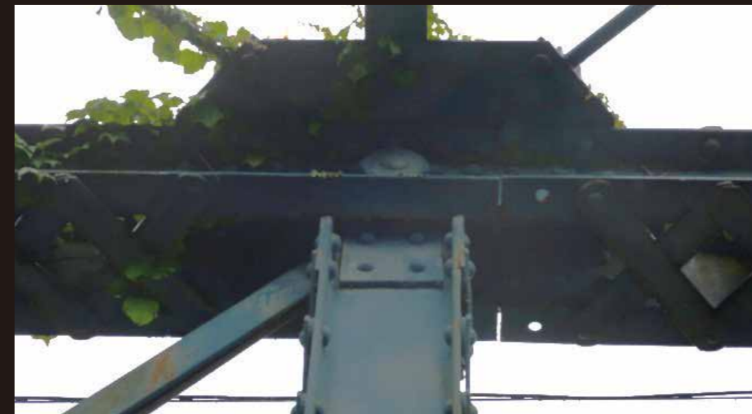
▲ トラス格点のピン構造部
