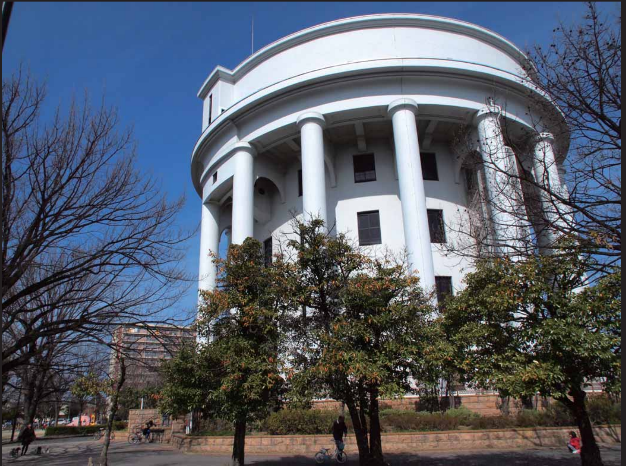
独特なフォルムを持つ旧稲葉地配水塔
