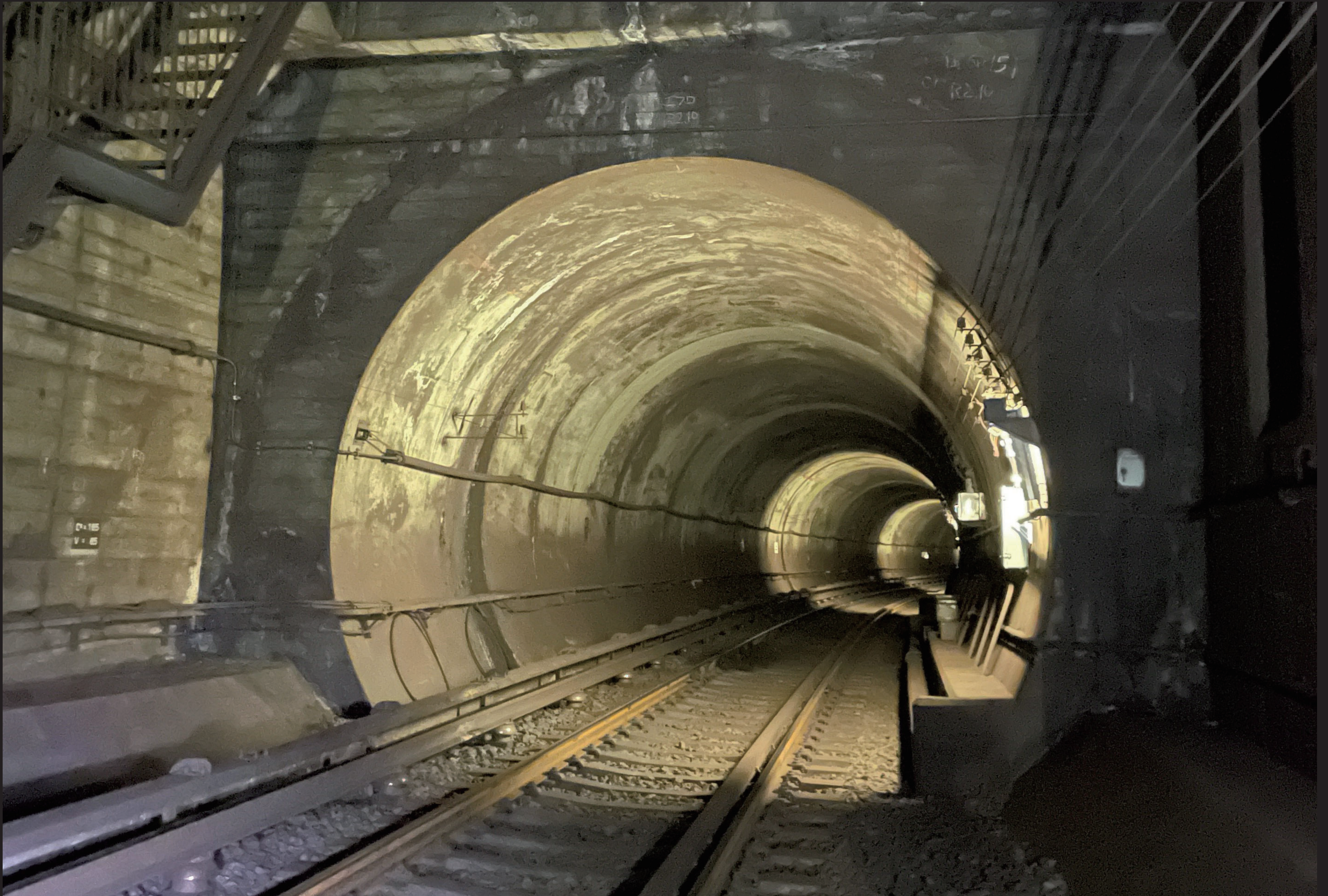
▲ 名古屋市営地下鉄池下駅側から見る坑口
